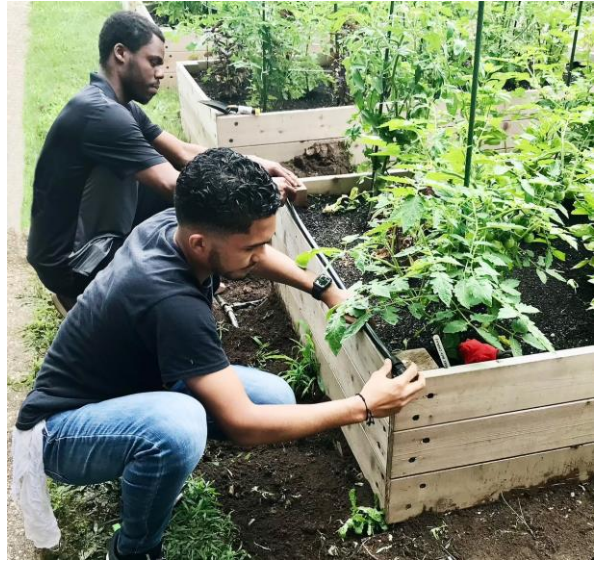
Working with Reconnect to install an irrigation system at the Monastery farm Trabajando con Reconnect para instalar un sistema de riego en la granja del Monasterio.
