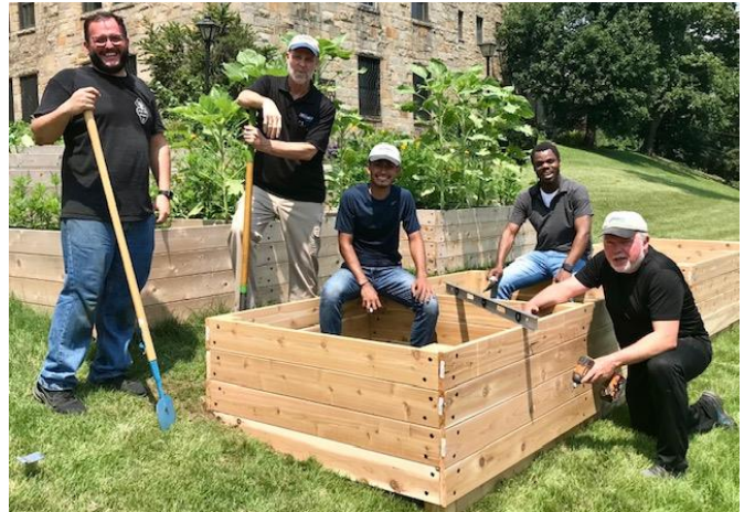
Working together to construct vegetable beds for the Farm Trabajando juntos para construir lechos de verduras para la granja
